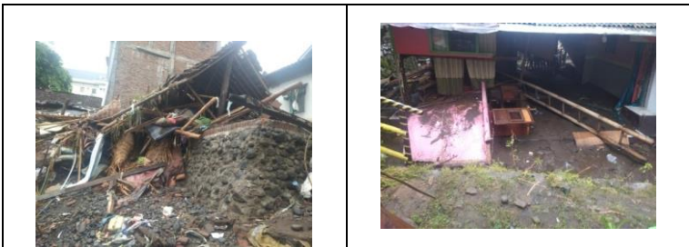
Gambar 4.14. Rumah warga Kampung Durenan yang roboh terkena banjir akibat meluapnya Sungai Bedadung Jember Sumber : dokumentasi Ibu Waginah, 2021
